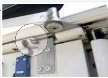
Vérouillage mécanique du portillon dès que la porte de garage s'ouvre
