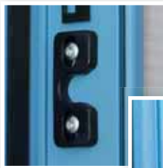
3 1 butée et 1 ergot anti-soulèvement par panneau
