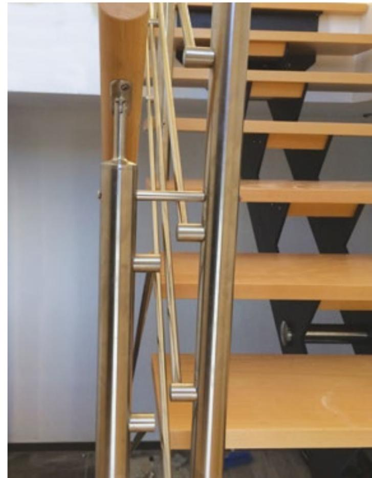
**▲ Ali.a. HÊTRE.** Escalier 1/4 tournant par le bas, sur crémaillères centrales avec entretoises inox, main courante ronde en bois, poteaux ronds et lisses inox en applique par fixation mécanique.
