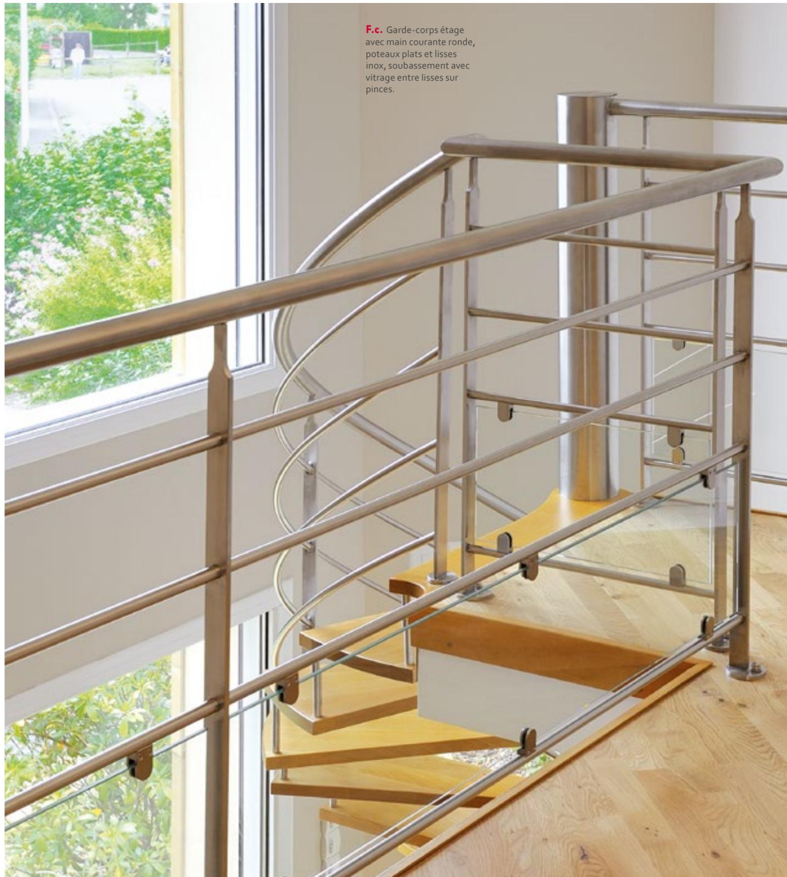
**F.c.** Garde-corps étage avec main courante ronde, poteaux plats et lisses inox, soubassement avec vitrage entre lisses sur pinces.
