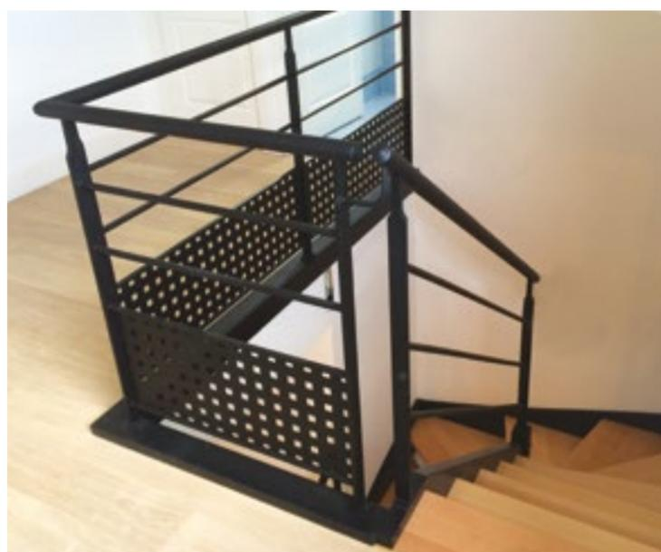
▶ **F.e.** Garde-corps étage avec main courante ronde, poteaux plats et lisses métal, thermolaqués effet structuré, soubassement en tôle perforée carrée.
